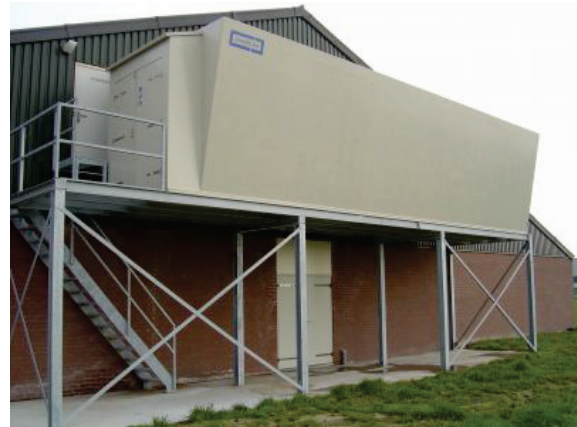
Abbildung 11: Abluftreinigung (Schweine- oder Geflügelstall) (Globogal AG, 2010)
