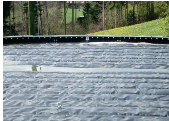
Abbildung 15: Schwimmfolie auf Güllesilo (FAT Tänikon, 2004)
