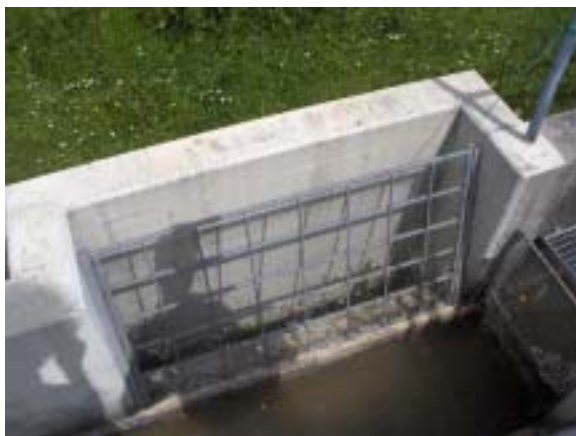
Abb. 3.4b Regenüberlauf vor der Wurzelkläranlage in Bargaen; Auslauf der Kläranlage in die Durach
