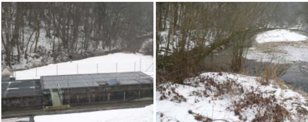
Abb. 3.2a ARA Schleithem am Zusammenfluss des Schleitheimerbaches und der Wutach (Jan.'06)
