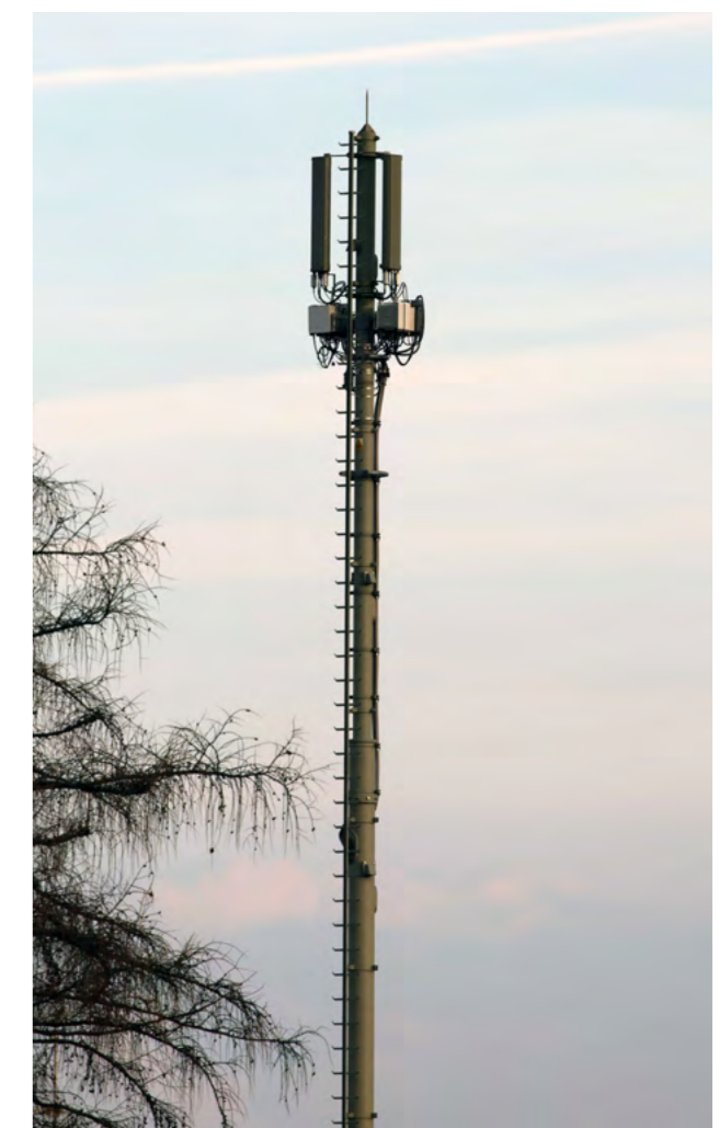
Mobilfunkantenne in Schaffhausen. Foto: is
