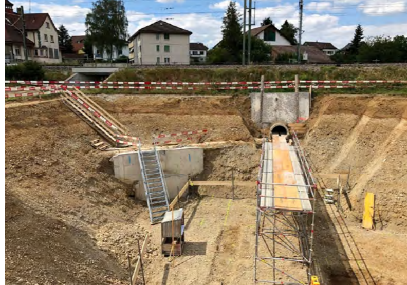
Baustelle des neuen Regenrückhaltebeckens am 11. Juli 2018. Foto: sd
