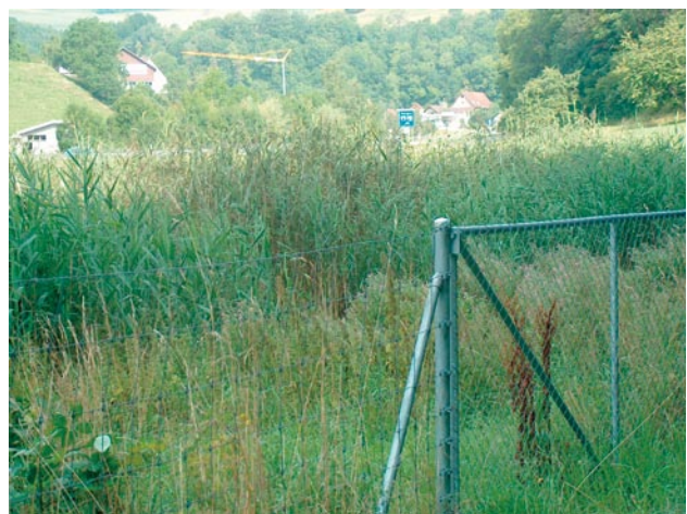
Die Wurzelraumkläranlage in Bargen - ein Pilotprojekt mit hoch gesteckten Erwartungen.
