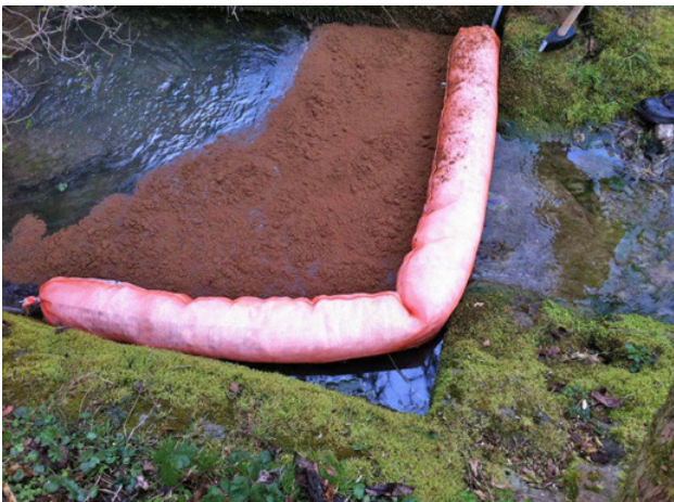
Absorbersperre, eingebaut durch die Feuerwehr Randental. Mit dieser Absorbersperre können Öl und Bindemittel zurückgehalten werden. Foto: P. Wäspi
