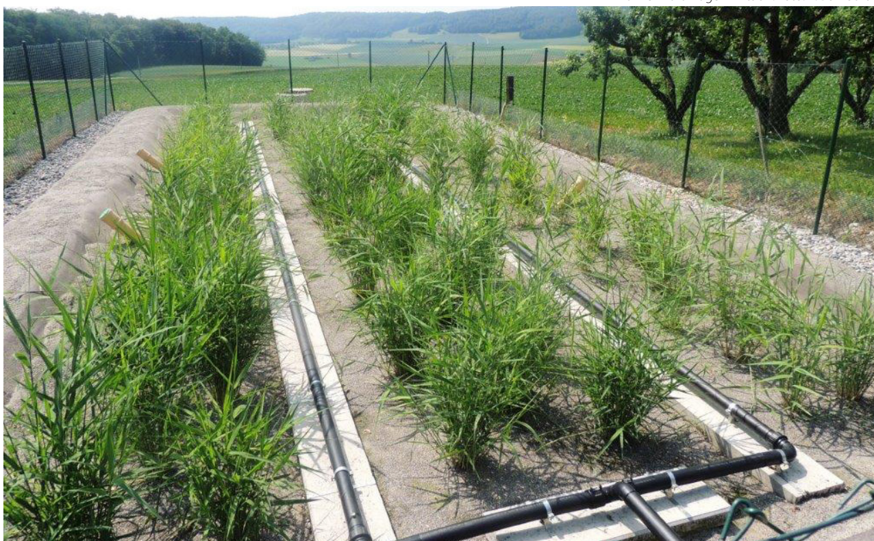
Pflanzenkläranlage in Altdorf. Foto: R. Bombardi
