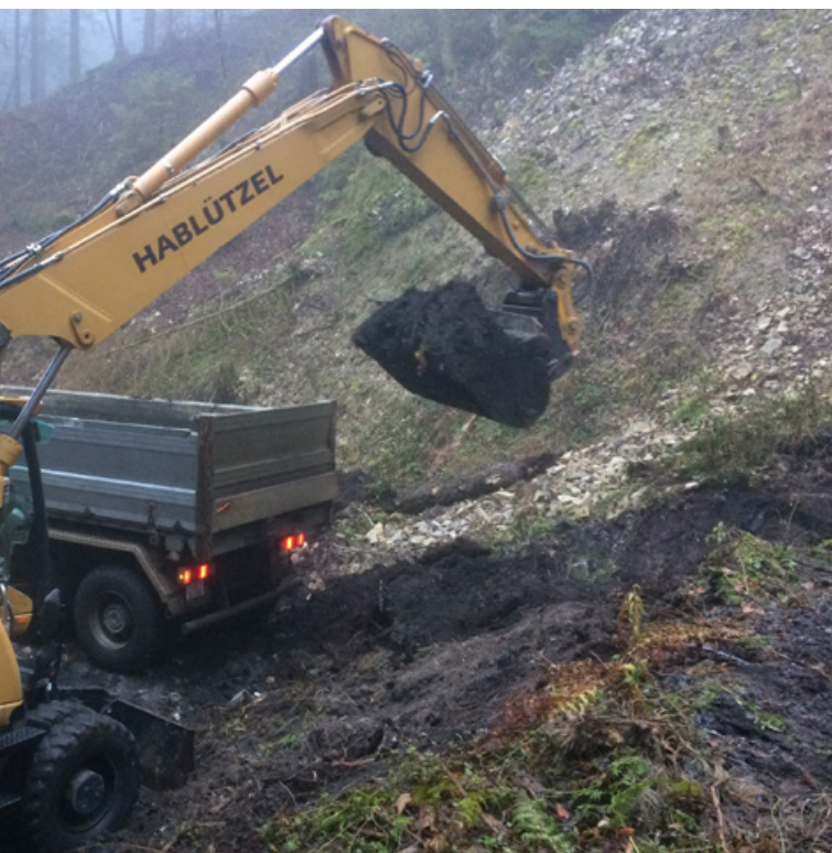
Ausheben und Abtransportieren der Abfälle im Steinbruch. Foto: J. Säggerer
