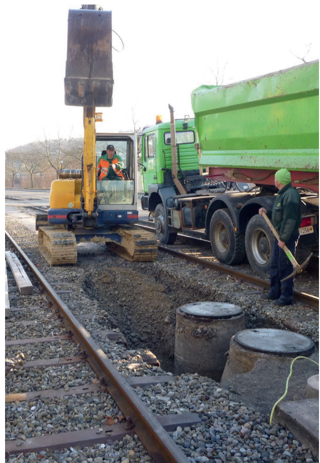
Aushub des mit Heizöl kontaminierten Bodens. Foto: P. Wäspi
