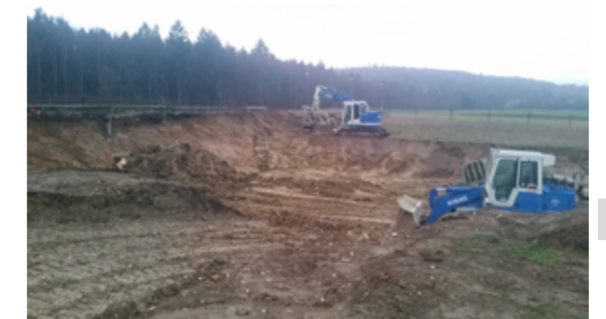
Sanierung der Kurzdistanz-Schiessanlagen Neuhausen Langriet. Foto: js
