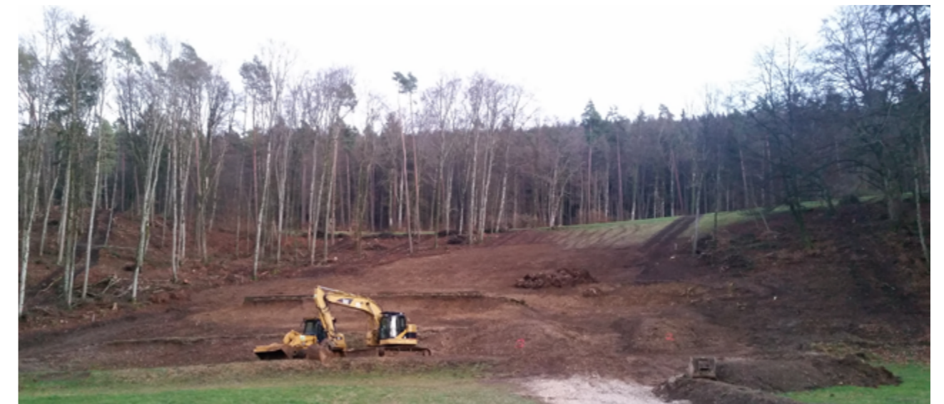
Sanierung der 300m-Schiessanlage Neunkirch. Foto: js
