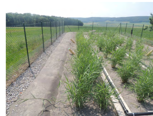
Eine Pflanzenkläranlage ist eine Möglichkeit einer dezentralen Abwasserreinigung. Foto: Bo
