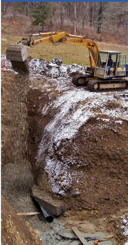
**Bauarbeiten im Bereich von Trinkwasserfassungen stellen eine erhöhte Gefahr für die Fassung und das Grundwasser dar. Besondere Massnahmen sollen eine Verunreinigung des Grundwassers vermeiden.**
